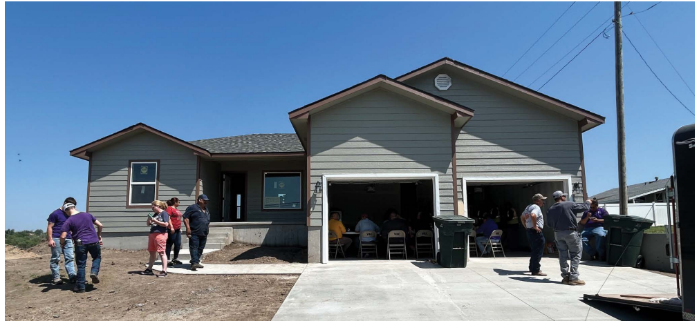
Imagen 12: CHAD y el programa DC3 Building Trades construyeron una nueva casa en 1306 Military Ave.
