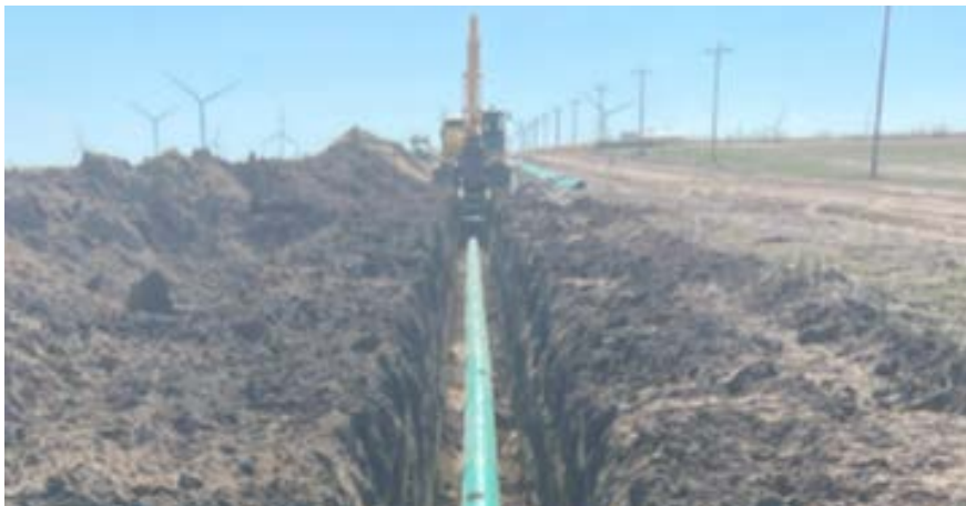
Imagen 29: Se instalaron 9.72 millas de tubería principal de fuerza de 16" desde la nueva Planta de Queso Hilmar hasta la Planta de Tratamiento de Aguas Residuales del Sur.
